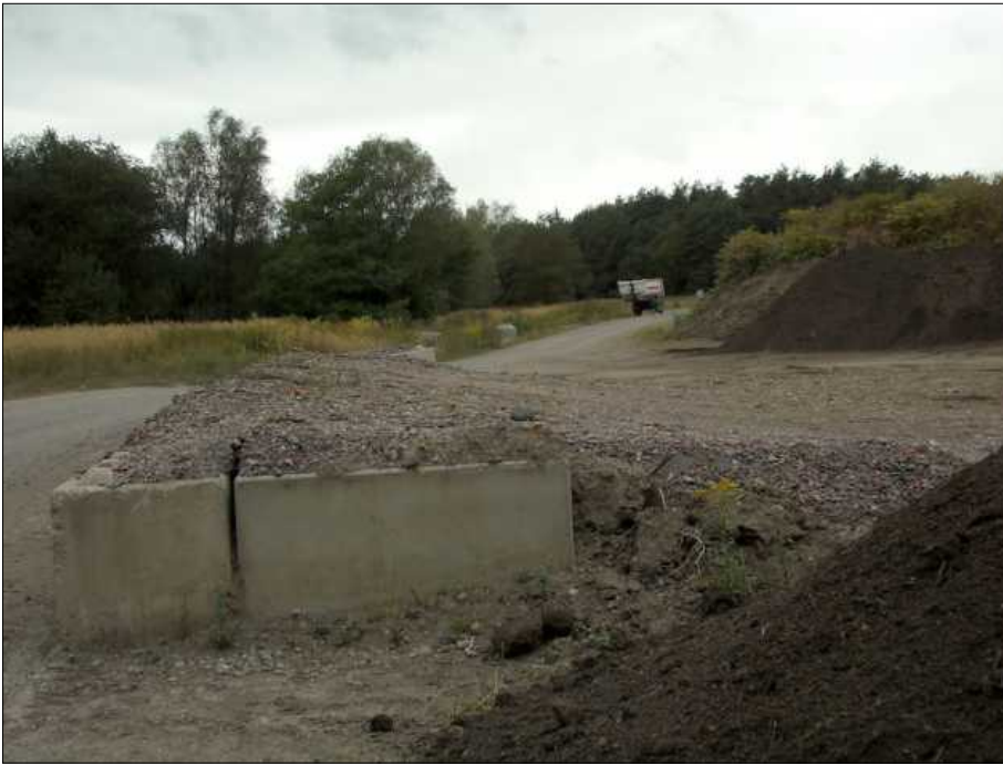
Foto 6: Betonelemente werden z.T. bereits bei der Abdämmung der Halden verwendet. Ein solches System kann auch zum Schutz von FFH-Anhang IV-Arten Schlingnatter und Zauneidechse entlang Nordrand der Ausgleichsflächen aufgestellt werden. Blick aus Ost nach West entlang Zufahrt. 24.08.18-HGF
