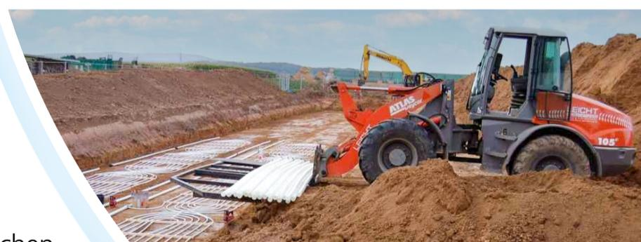
In einer Tiefe von eineinhalb bis drei Metern liegen die Kollektoren in zwei Schichten unter der Erde. Die Fläche darüber wird weiterhin bewirtschaftet.
