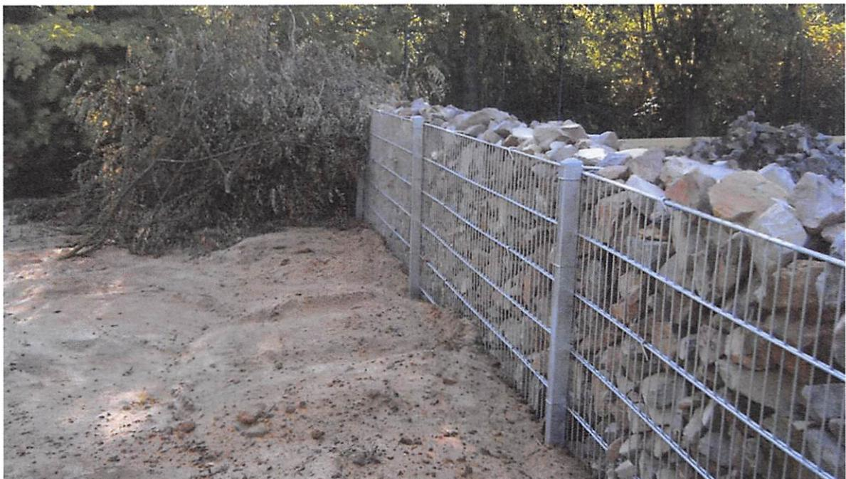
Foto 12 Fertiggestellte Gabione mit Sand im Umfeld zur Ermöglichung einer Eiablage von Reptilien
